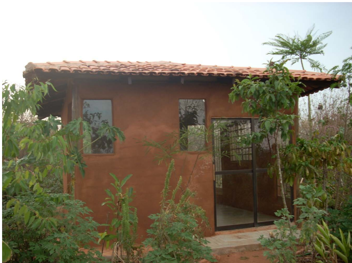
Vista externa da casinha recém rebocada.
