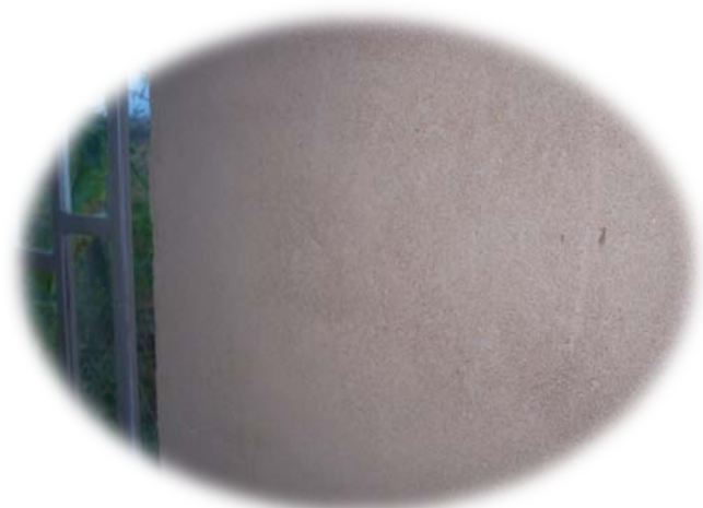
Textura do reboco
